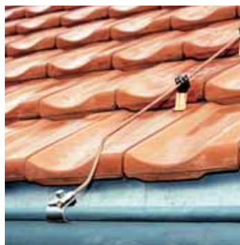
Funktionalität auch im Detail: die elektrisch leitende Verbindung vom Fangleiter über Dachrinne und Ablaufrohr zum Erder. (Bilder: Arthur Flury AG)
