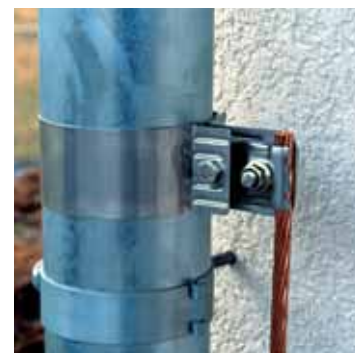
Funktionalität auch im Detail: die elektrisch leitende Verbindung vom Fangleiter über Dachrinne und Ablaufrohr zum Erder. (Bilder: Arthur Flury AG)
